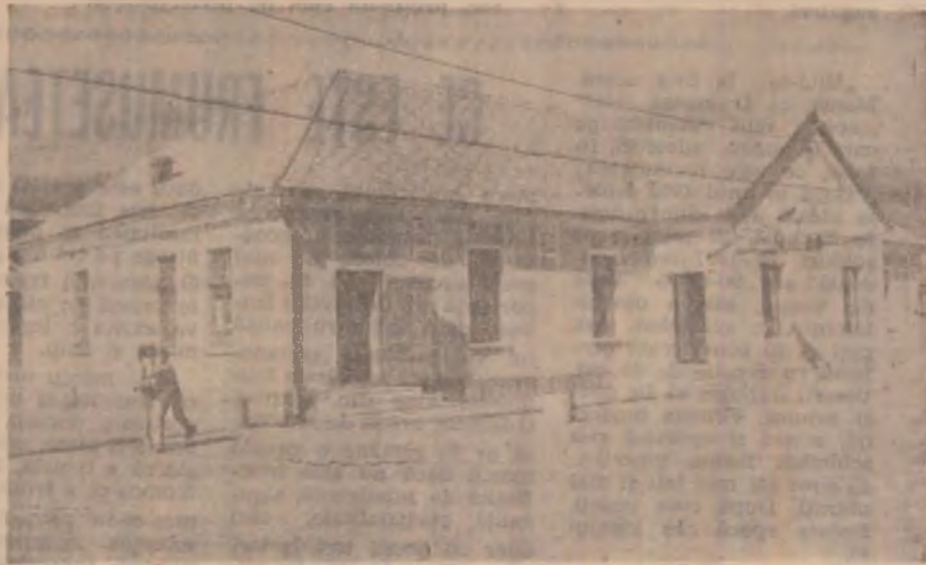
Așa arată după renovare sediul Primăriei și al Consiliului local Certej. Foto: ANTON SOCACI
