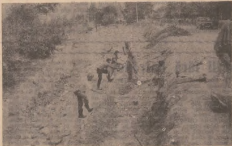
În comuna Densuș se execută un zid de protecție a șoselei pe pârâul Galbena.
