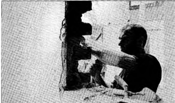
Când faceți lucrări de construcții în locuință, anunțați administratorul blocului
