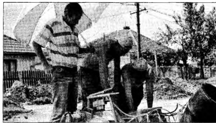
Lucrările la rețeaua de alimentare cu apă vor termina probabil în septembrie
