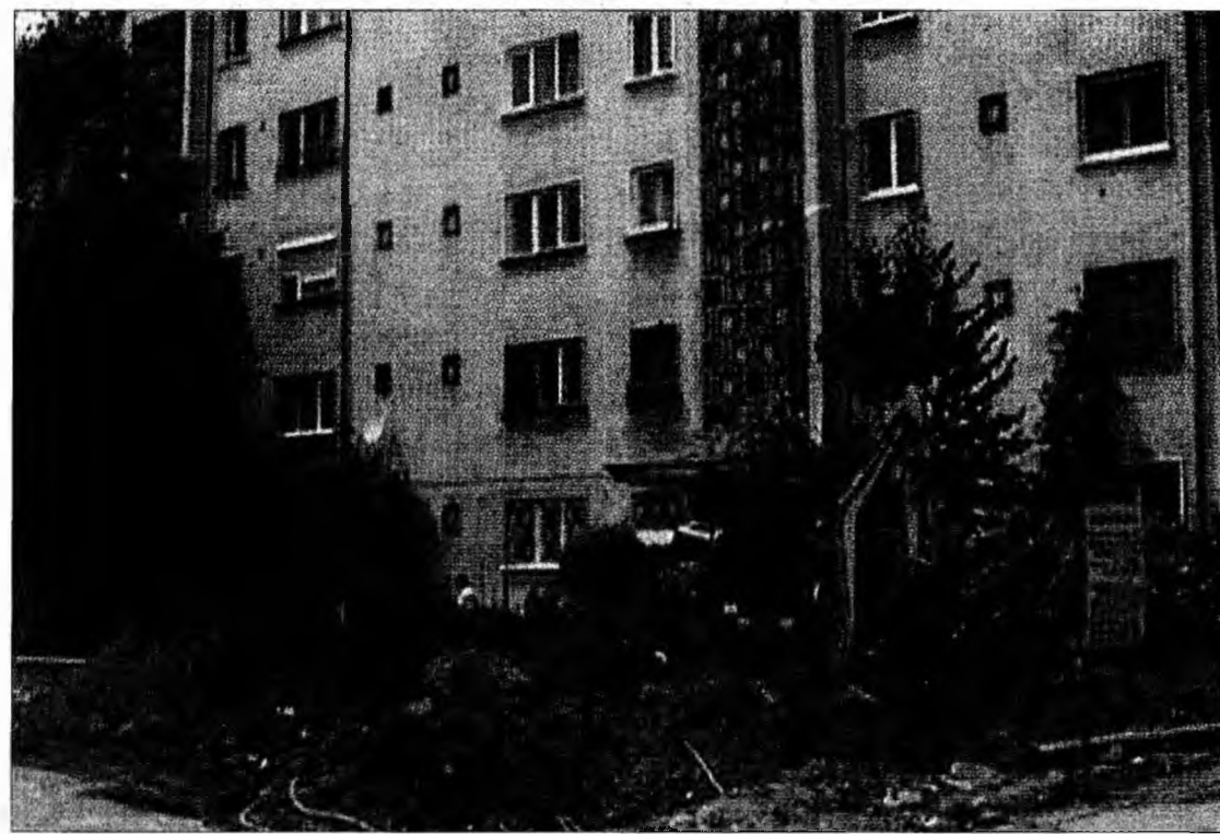
Lucrările de construcție ale noului imobil au fost sistate
