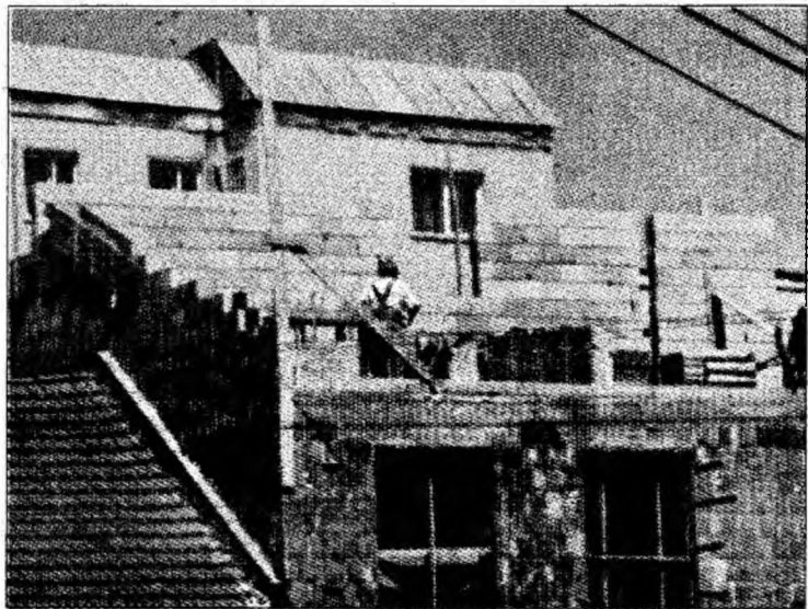
În spatele blocurilor de pe strada Cernei se construiește susținut
