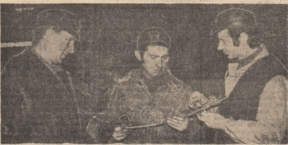
C.S.M. Laminorul de sirmă I. Maistrul laminator Emilian Onea împreună cu laminatorul Ioan Ardeleanu și Ilie Clorogaru, verifică la micrometru dimensiunea unei probe de sirmă pentru export.
