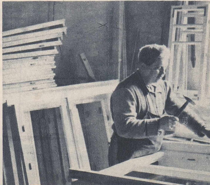
Timplarii gospodăriei lucrează de zor rame de ferestre și uși pentru noile case pe care și le construiesc colectivii.
