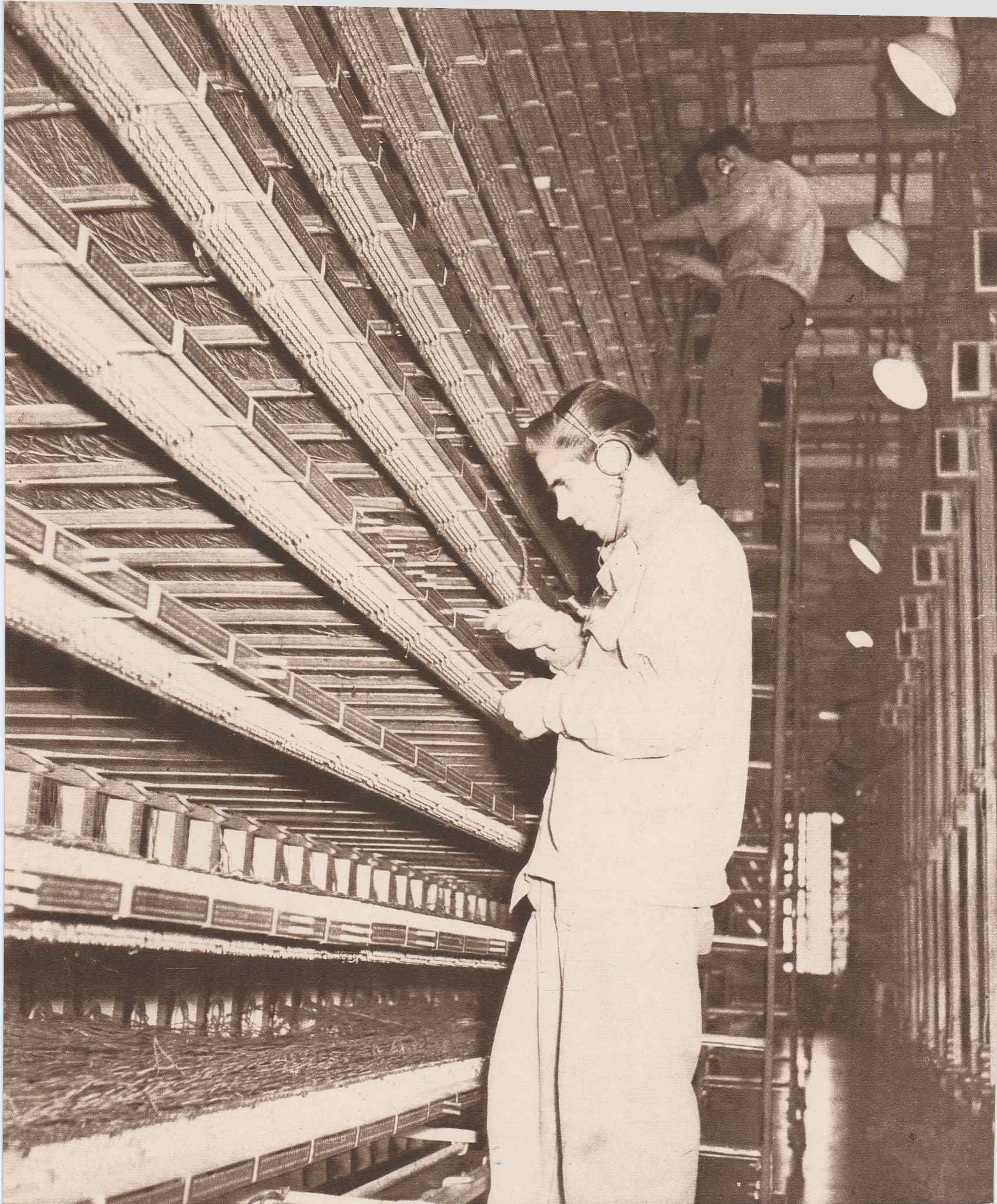
Zeci de mii de fire telefonice se întretăie aici, într-una din secțiile centralei Victoria I. Mecanicul Mihai Tăbîrcea veghează la buna funcționare legăturilor telefonice, înlăturînd operativ defectele.
