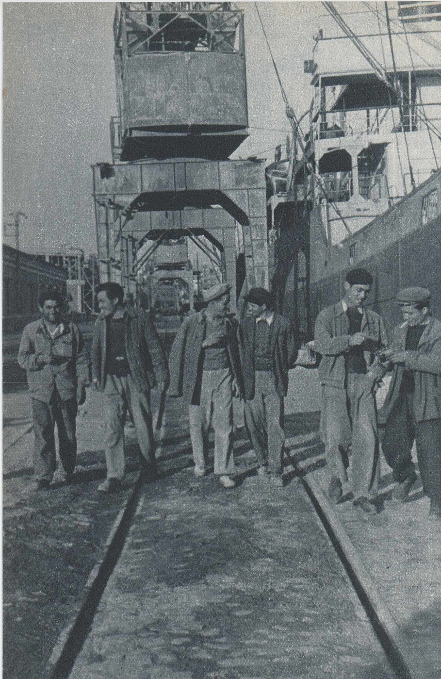
Ora prinzului. S-au oprit brațele uriașelor macarale; s-au oprit autostivuitoarele, bi-gile, rutierele. Muncitorii se îndreaptă spre cantină.
