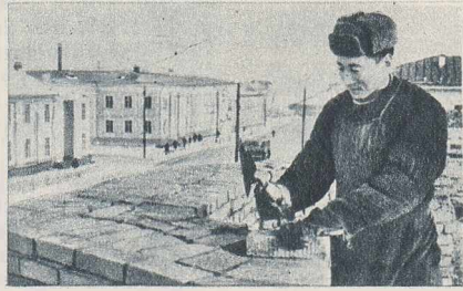
Construcția unei noi case de locuit pe str. Oktobriiskaja din Iakutsk.
