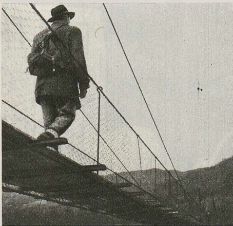
PESTE VALEA CĂTINEI au fost construite — în anii puterii populare — nenumărate poduri suspendate. Aceste poduri, de peste 100 m lungime, ușurează trecerea văii, care se făcea pe niște punți improvizate din scinduri și pietroale ce preveneau nenumărate accidente.
