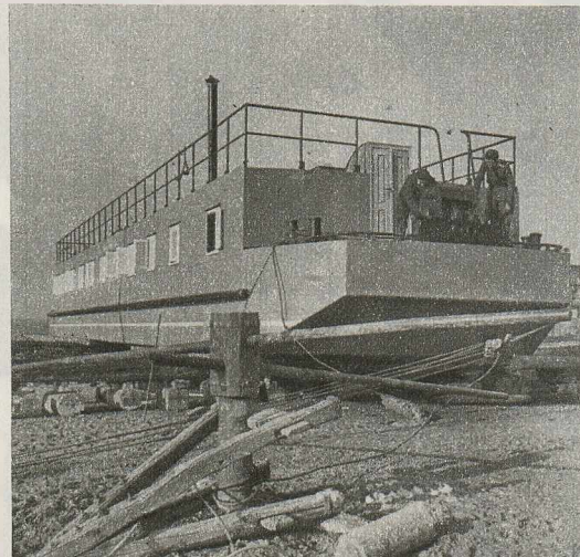
DORMITOARE PLUTITOARE PENTRU MUNCITORII DIN DELTA DUNĂRII. Atelierele navale din Smîrdanul Nou — reg. Galați — construiesc pontoane-dormitoare cu o capacitate de 50-80 de paturi. Dormitoarele plutitoare sînt prevăzute cu încălzire centrală, bucătării, băi, săli de mese etc.
