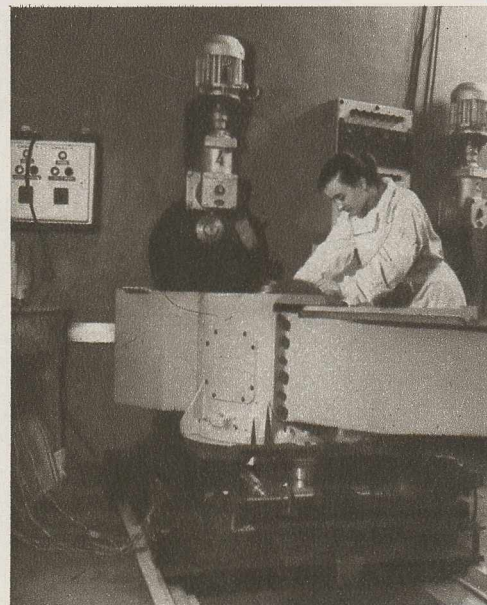
SPECTROGRAFUL DE NEUTRONI — pe care-l verifică Valentina Belicov, de la Institutul de fizică atomică, înainte de a fi pus în funcțiune — și selectorul de neutroni sînt primele echipamente complexe de cercetare în domeniul fizicii nucleare, realizate în țară.
