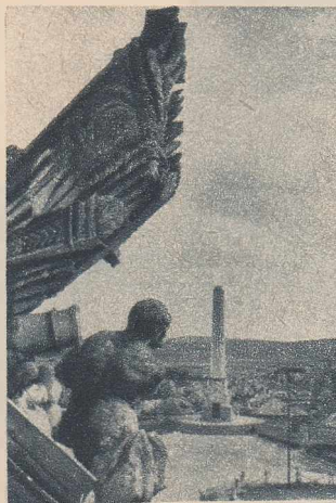
Monumentul închinat lui Horia, Cloșca și Crișan văzut de pe una din porțile cetății.
