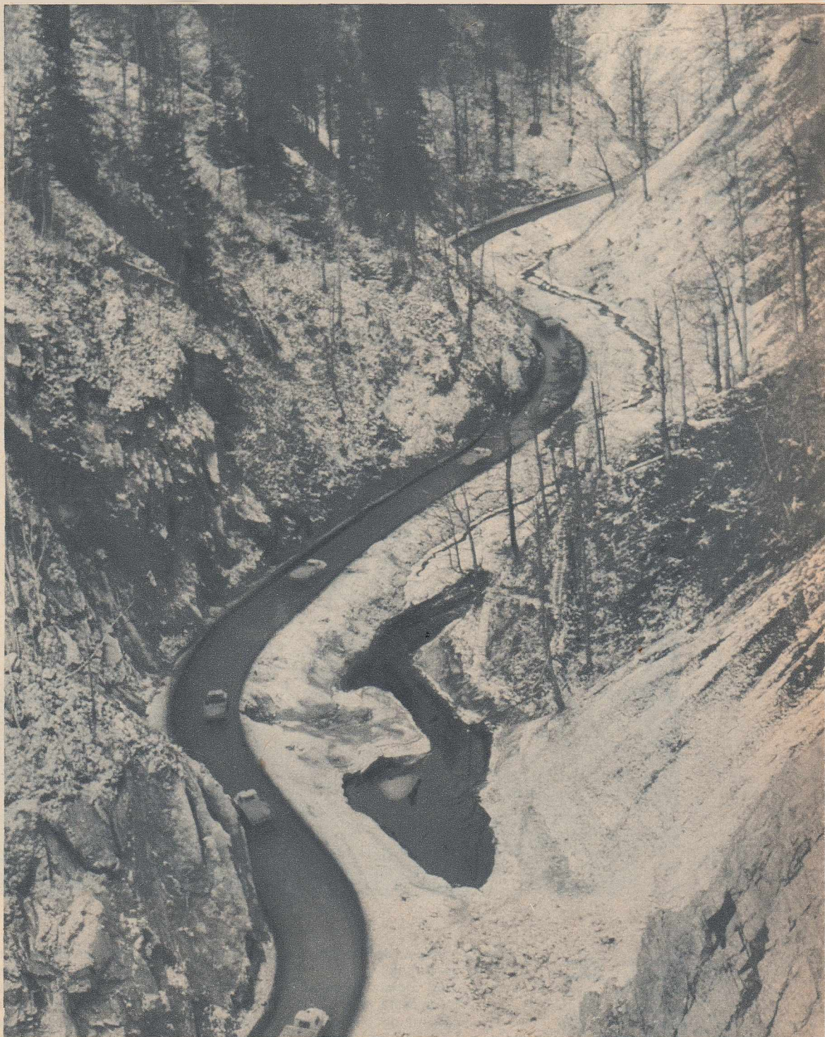
Șoseaua spre coronamentul barajului, lungă de 5 kilometri, arcuită peste poduri și viaducte, a fost săpată în întregime în stîncă.
