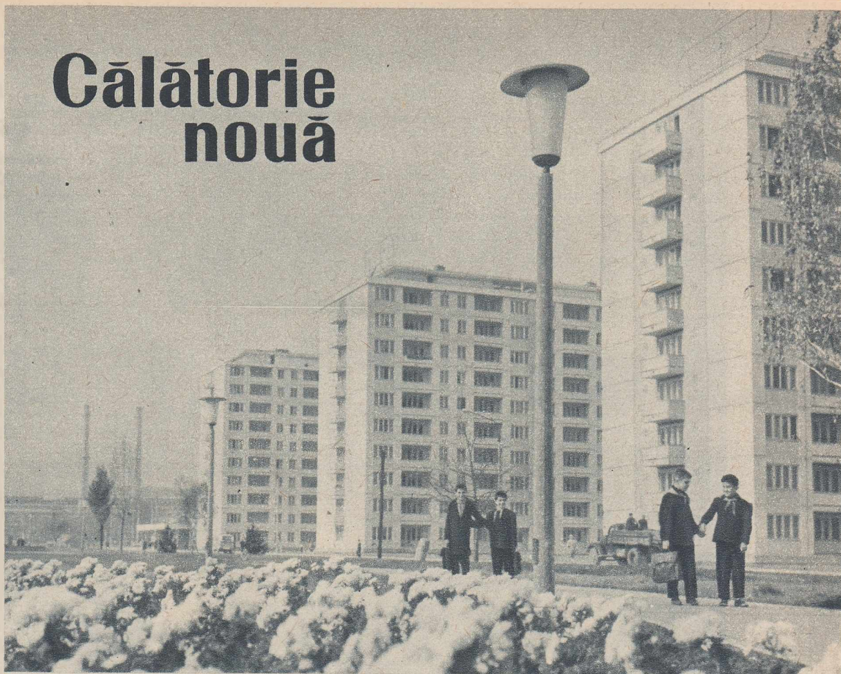
Hunedoara azi: beton, sticlă și oțel.
