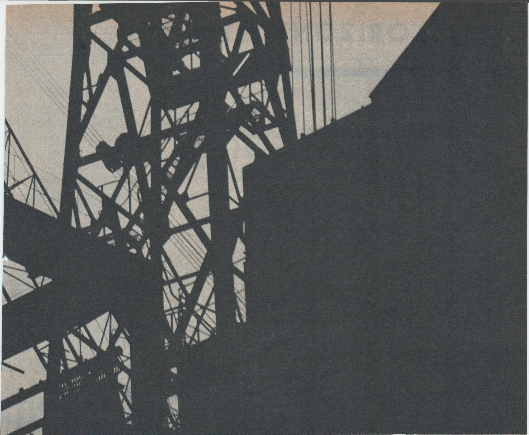
▲ O parte din pădurea metalică a Termocentralei de la Işalniţa. Aici se vor produce, în 1969, 7 miliarde kWh energie electrică.
