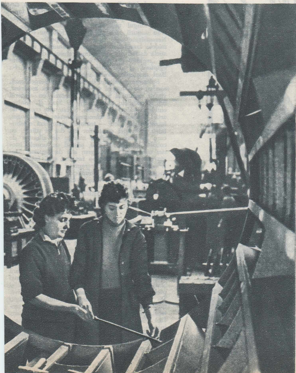
Carcasa statorului unui generator de mare putere în montaj la fabrica Ganz.
