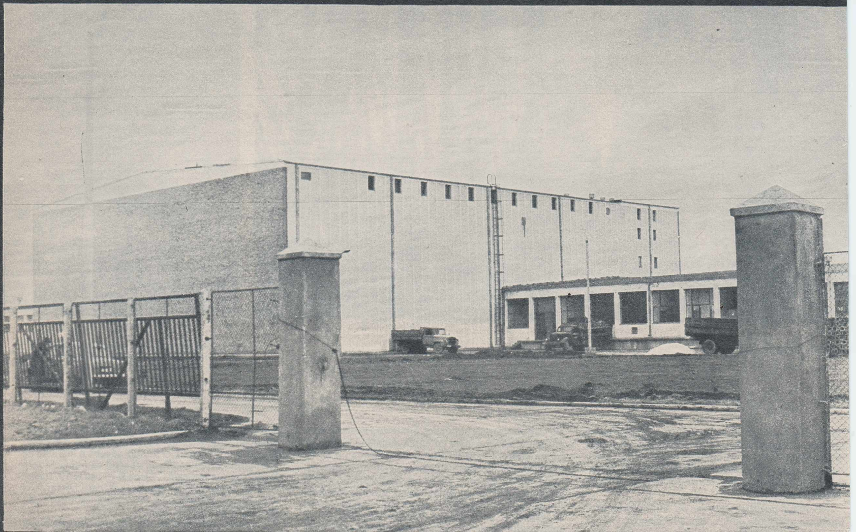
Văzută de la distanță, noua clădire a Centrului de depozitare și îmbuteliere a vinului din Galați arată, ce-i drept, destul de bine. Dar e de ajuns să te apropii...
