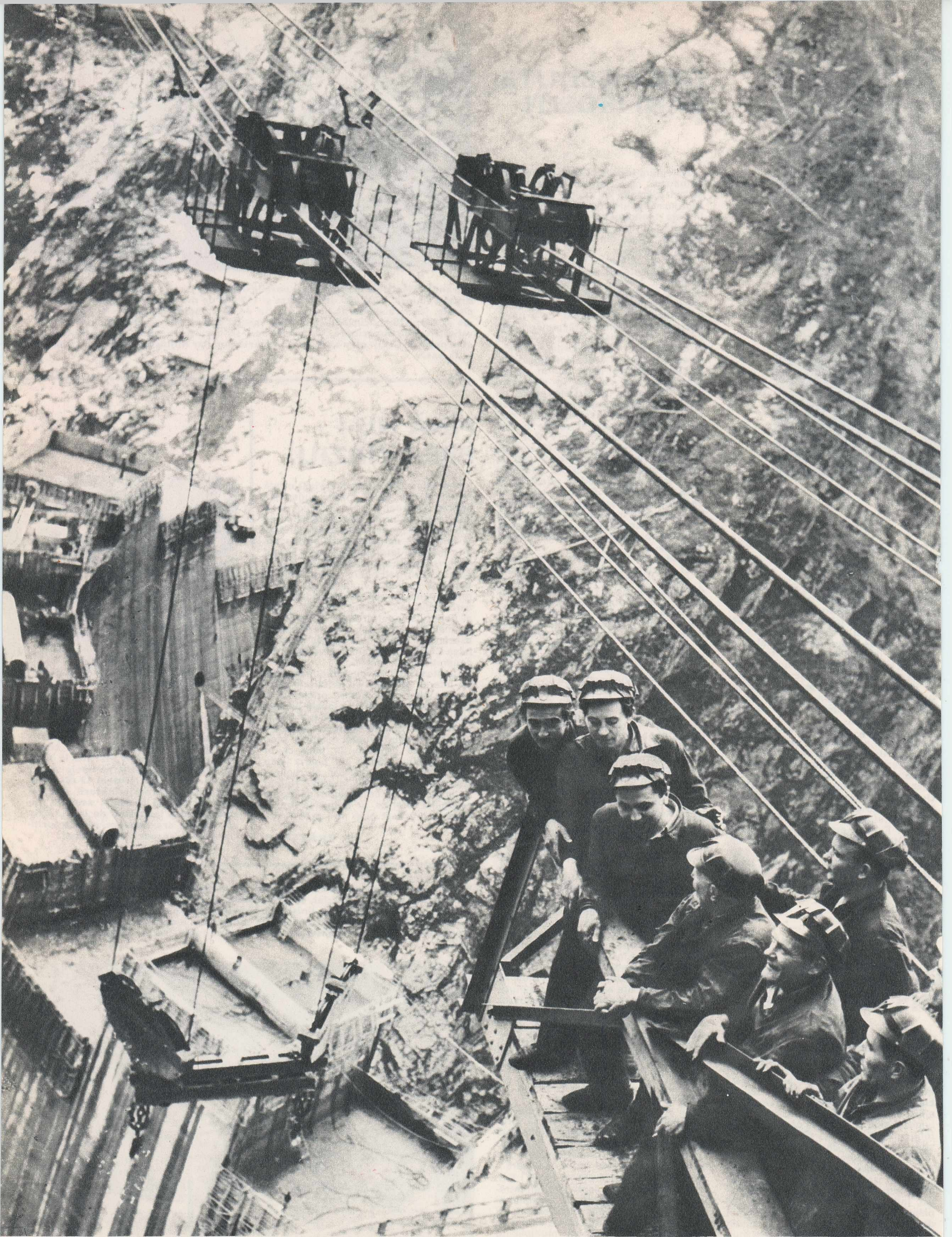
Brigada de funiculariști condusă de maestrul Ștefan Topală, care a transportat pe calea aerului nu numai milionul de metri cubi de beton ai barajului de la Bicaz ci și uriașul volum de agregate turnate în corpul «muntelui artificial» de la Argeș.
