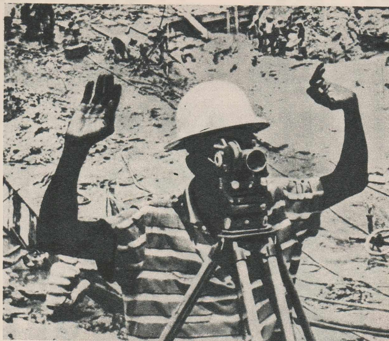
Șantierul unui complex industrial. Strădania statelor Africii negre de a-și croi drumul spre independență economică și bunăstare se concretizează în fabricile și uzinele, hidrocentralele și căile ferate, școlile și universitățile ce se înmulțesc.
