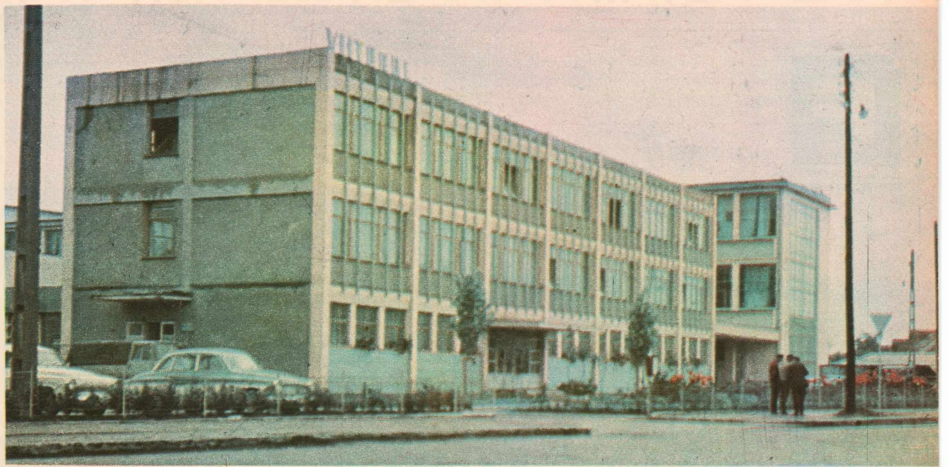
Noua construcție a fabricii «Viitorul» din str. Cluj nr. 175, Oradea.
