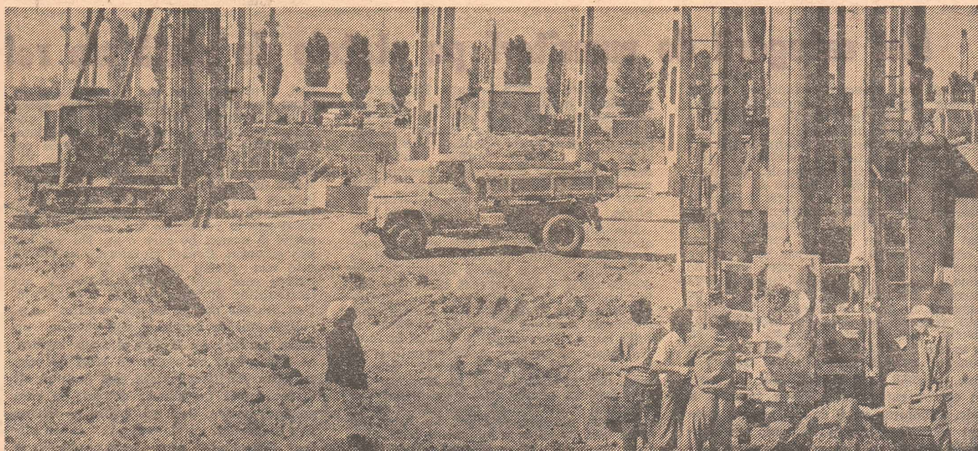
Ritm înalt și susținut pe un șantier din inima Bărăganului
