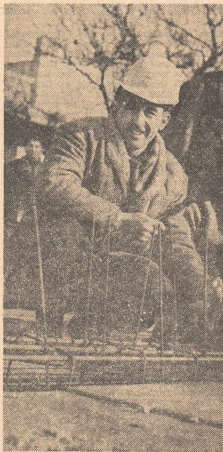
Nițu Ion, șeful unei echipe de fierar betonisti
