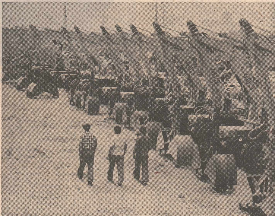
Excavatoarele sau „castorii“ șantierelor
