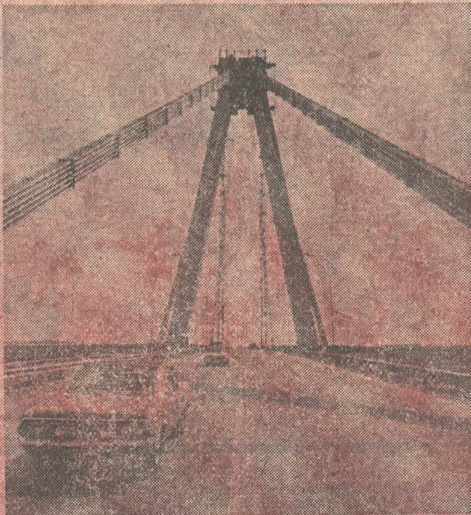
Rod al unor soluții tehnice autozileatoare, originale, podul de la Agigea e unul din cele 11 ce vor traversa canalul
