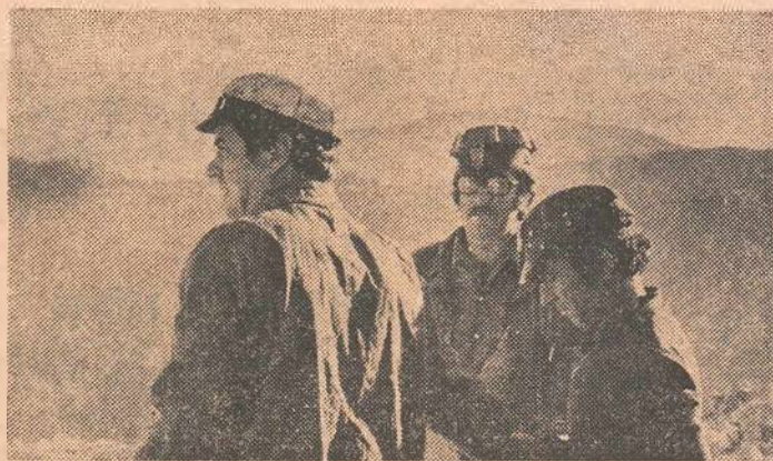
Inainte de infruntarea cu roca
