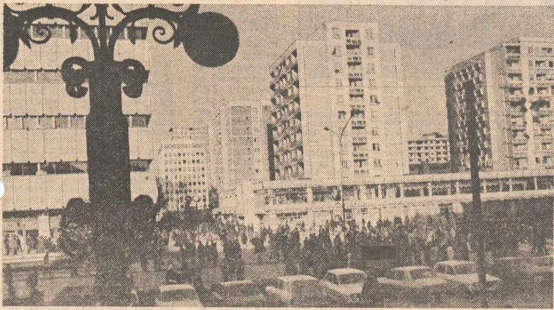
Imagine familiară în fiecare localitate a țării: noi construcții edilitare, noul chip al oraselor
