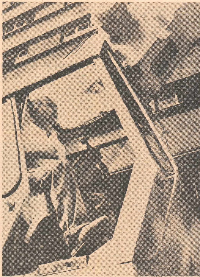
Anghel Rumeaga și macaraua sa — doi dintre eroii noului nostru reportaj de pe șantierul metroului
