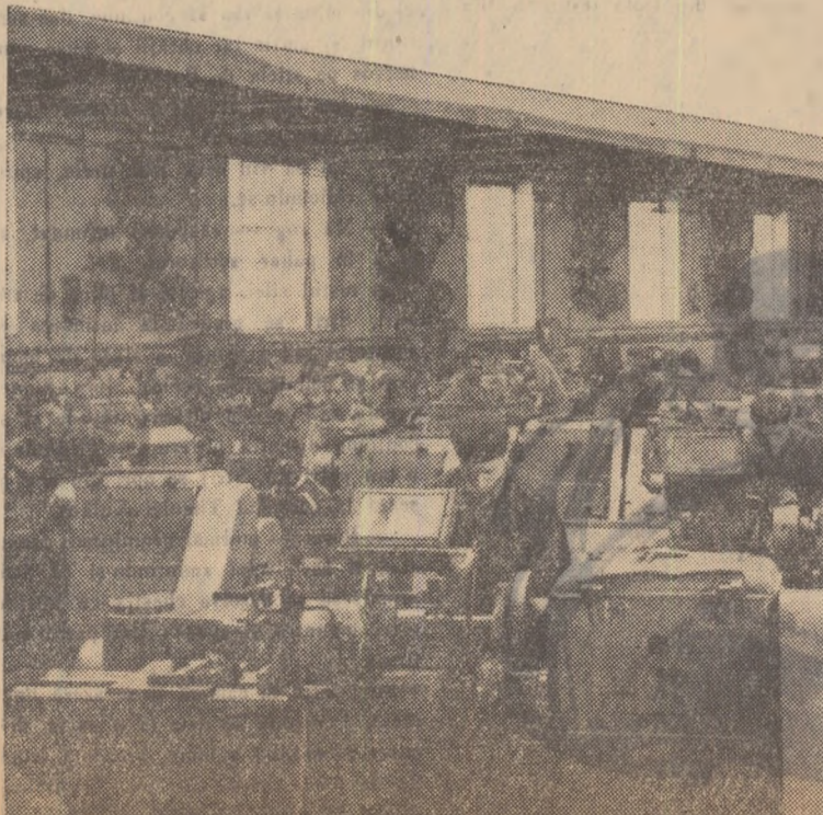
Atelierul de sculărie de la Complexul C.F.R. „Grivița Roșie“.
