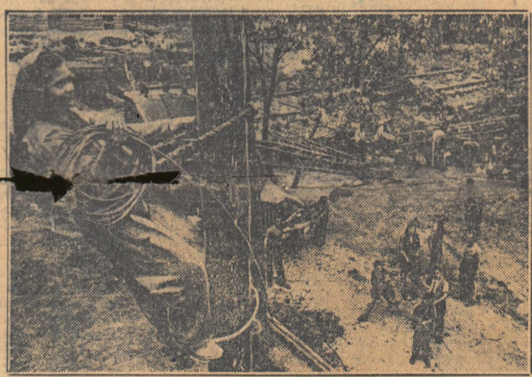
Pe șantierul tineretului din Cluj, unde se construiește un cămin studentesc, eleva Nastasia Mureșan, de la Școala profesională de construcții nr. 4 Cluj, lucrează la instalațiile electrice.
