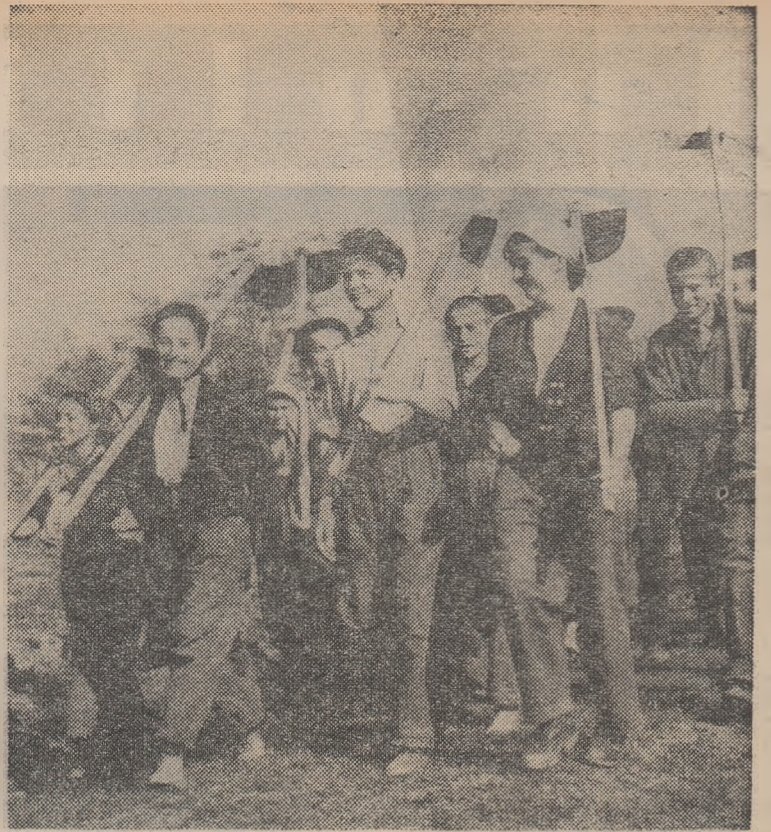
Numeroși elevi au participat cu entuziasm la lucrările de terasare. Iată un grup de elevi din Turda pornind spre locul de muncă.
