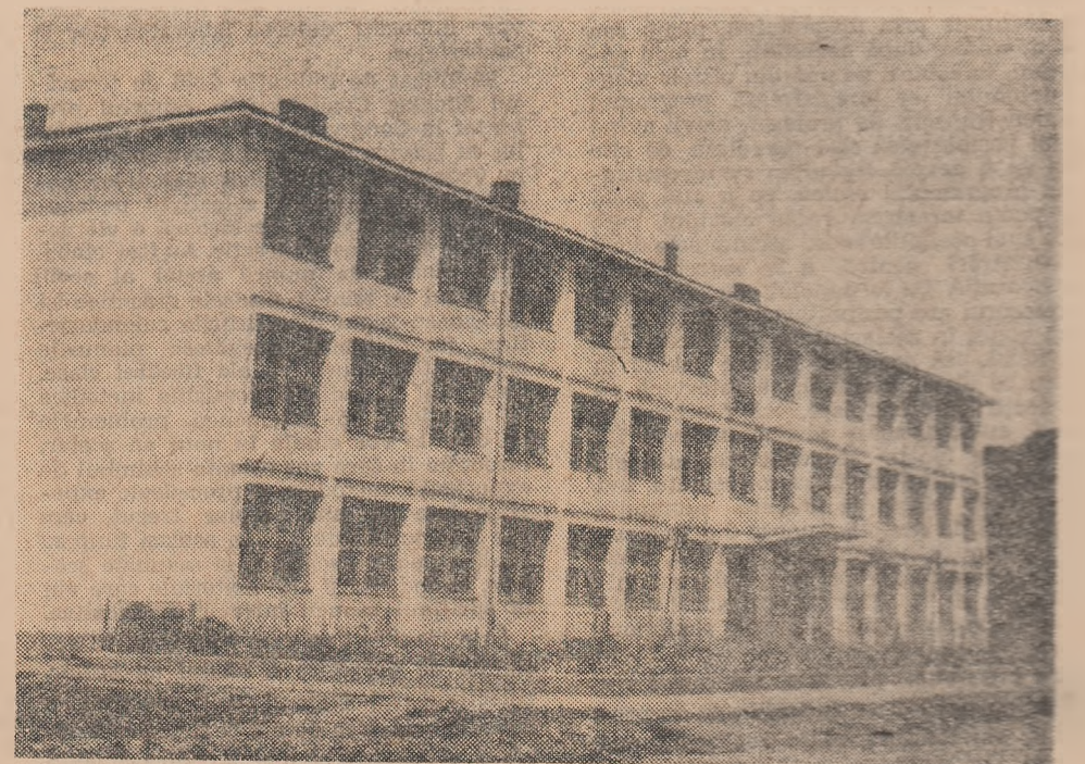
Construcția recent terminată a Școlii generale din comuna Sebiș reg. Crișana
