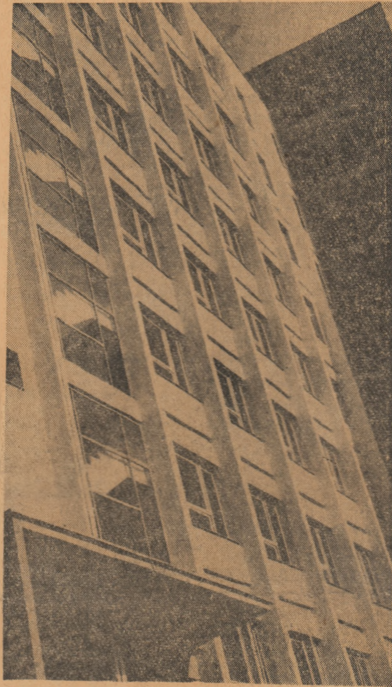
Una din noile clădiri construite în anul 1966, a Complexului studentesc din orașul Cluj.
