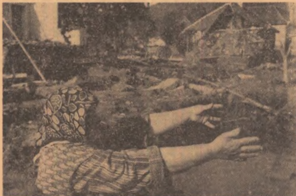
Sighișoara — Valeria Coman: „Asta a fost strada Clujului”
