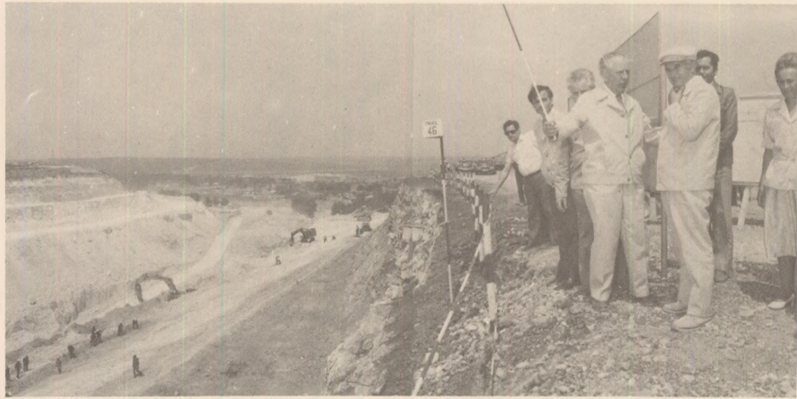
Pe șantierul Canalului Dunărea-Marea Neagră, analizând stadiul lucrărilor
