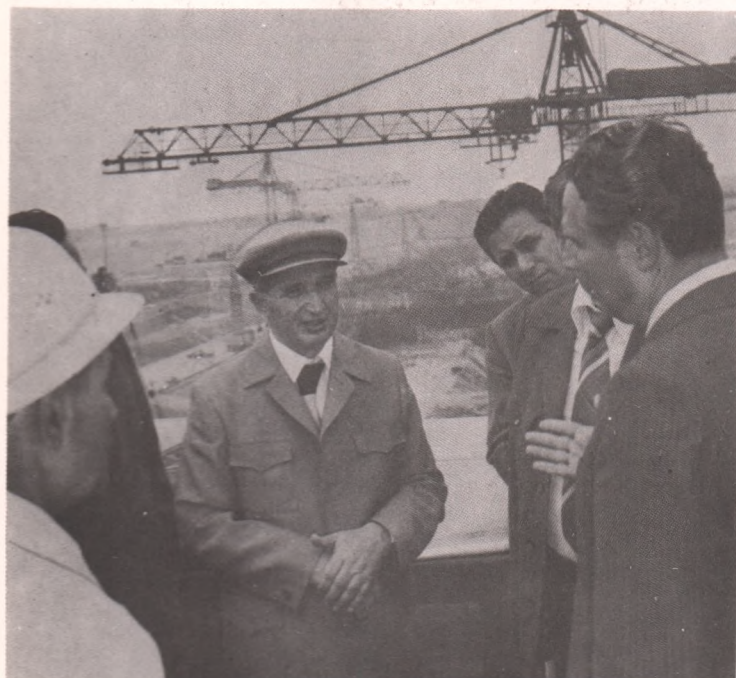
Pe șantierul hidrocentralei Porțile de Fier (II)
