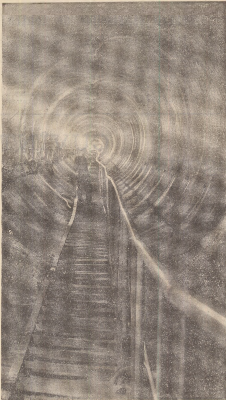
Galeria de forță într-o fază avansată
