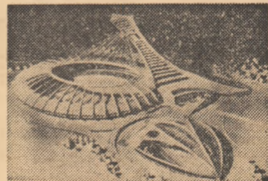
Stadionul de la Montreal — Canada
