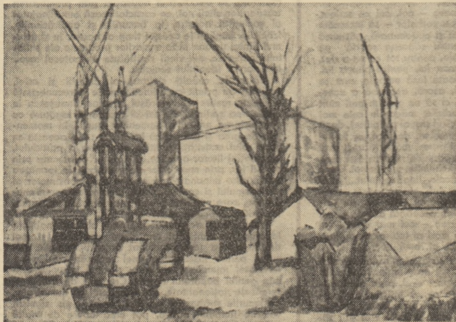
ION RESSU : Construcții noi
