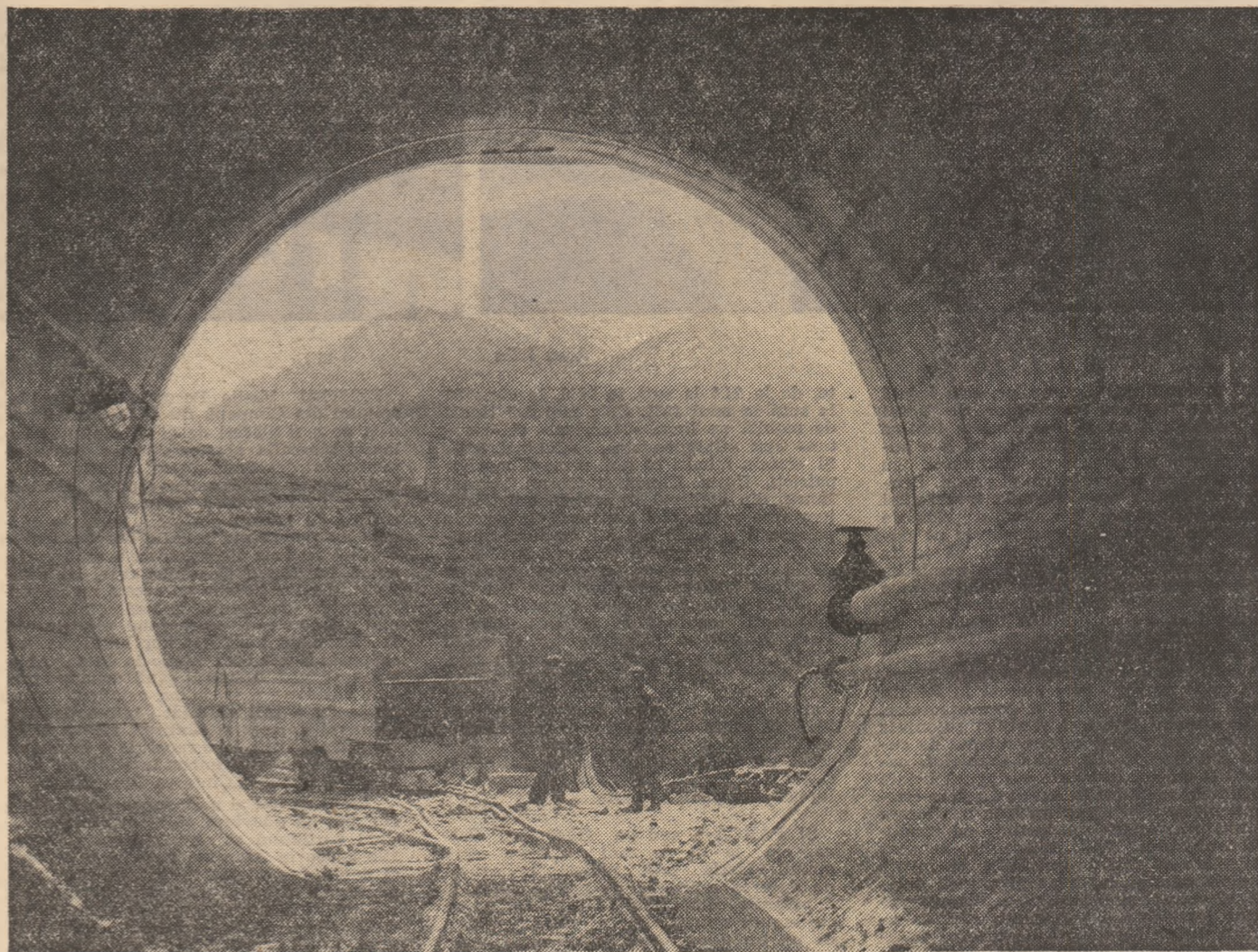
Pe șantierul hidrocentralei Riul Mare
