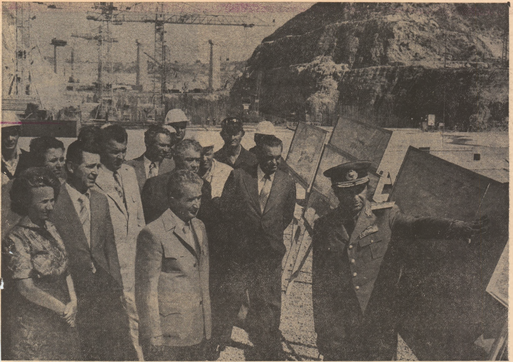
Pe șantierul Canalului Dunăre - Marea Neagră
