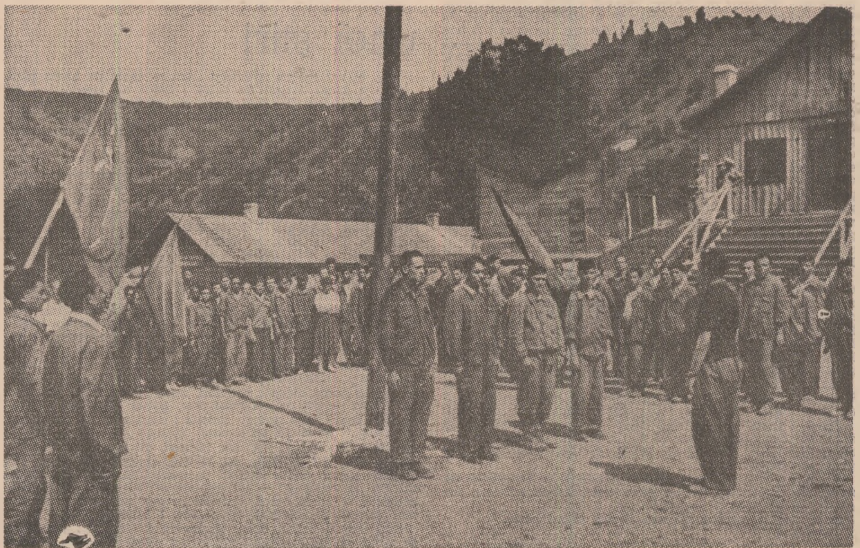
Brigadierul pe șantierul Hidrocentralei de la Bicaz
