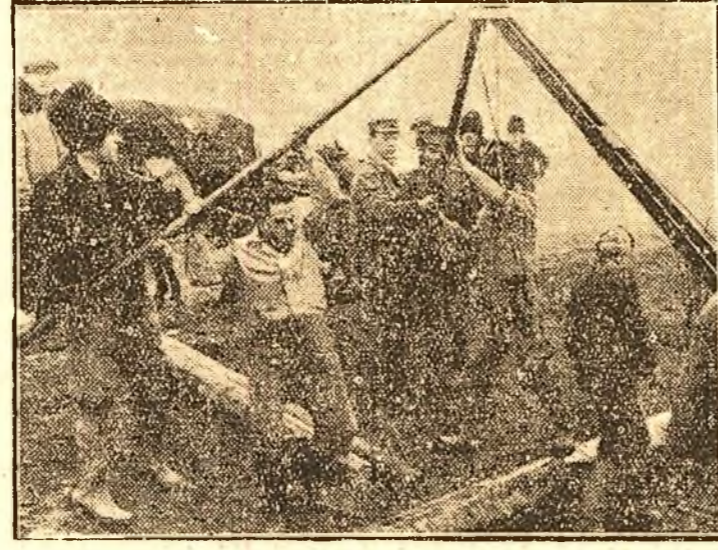
Acum se fixează macaraua. Căteva minute și conducta va fi coborâtă în șant
