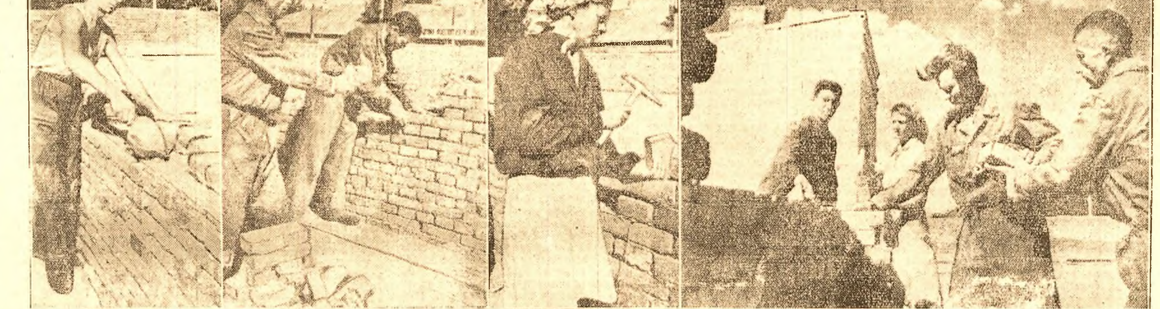
Metoda sovietică folosită de zidarul gălățean Luigi Strenati se compune din următoarele faze redatăe în clișeele de mai sus (dela stânga la dreapta): 1) Primul ucenic întinde mortarul; 2) al doilea ucenic îi dă cărămida la mână lui Luigi Strenati iar acesta o potriveste în stratul de mortar; 3) Ultimul ucenic — în cazul de față o țărâșă — astupă golurile cu bucați de cărămidă și mortar. În ultimul clișeu se poate observa întreaga echipă lu lucrul.
