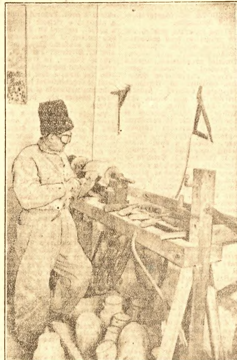
Și în atelierul de tâmplărie, fiecare clipă este prețioasă. Iată-l pe tovarășul Gheorghe Nedea lucrând la strung butuci pentru route de carușă.
