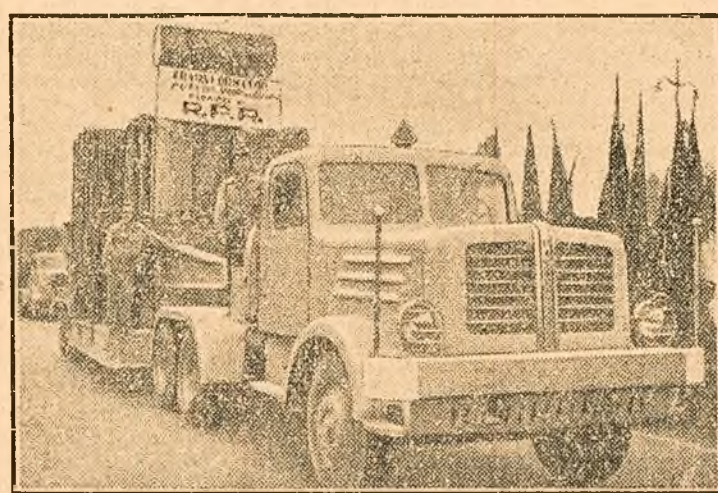
Stărnind admirația celor din tribună, trece unul din autocamioanele grele fabricate pentru prima oară la noi în țară, în uzinele „23 August”, având pe remorcă un puternic transformator de 10.000 kVA
