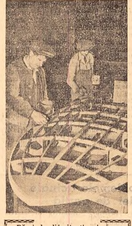
Bărți de diferite tipuri și profile, planeare, instrumente sportive și muzicale și multe altele produse fine din lemn în mîna harnicilor muncitori de la IFIL-Reghin. În clișeu: maestrul Iosif Bende și muncitorul Gavril Rusu vopsesc glisorul unei ambarcațiuni.
