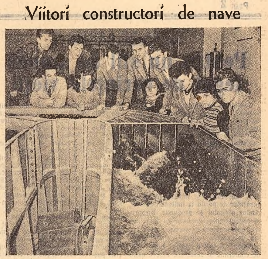
Viitori constructori de nave Înainte de a fi ei înșiși constructori de nave, studenții de la Institutul politehnic din Galați învață în laboratoarele tehnice navale, în clădirea studențescă din anul V asistând la probele eliceilor care se fac în bazinul de experimentare. (Foto: GH. VINTILA)
