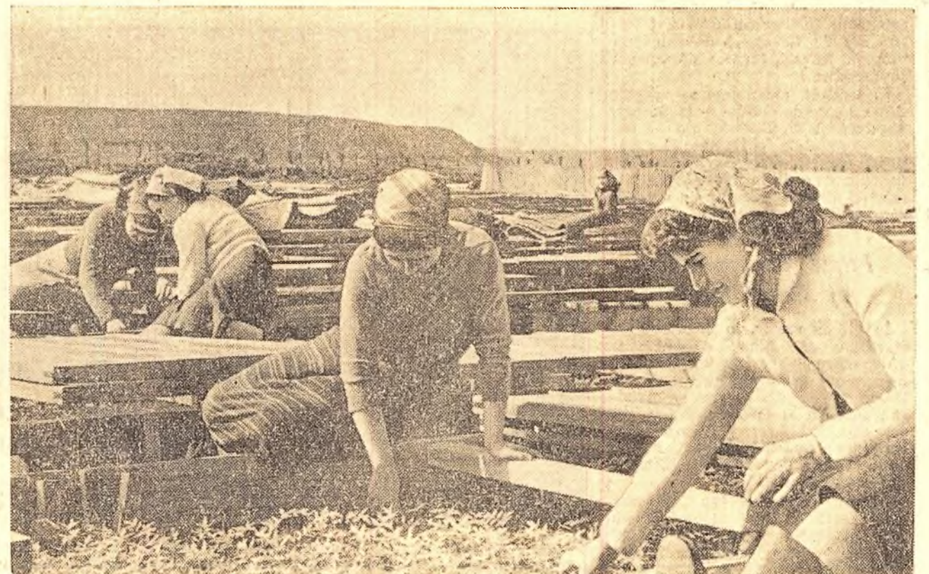
Pentru a contribui la aprovizionarea populației din Capitală, la G.A.S. Popoști-Leordeni se cultivă 428 ha. de legume. În aceste zile, la secția seră se lucrează de zor la replicatul a fost replicat 220.000 fire de răsad de roșii și 90.000 fire de răsad de varză și conopoli.
