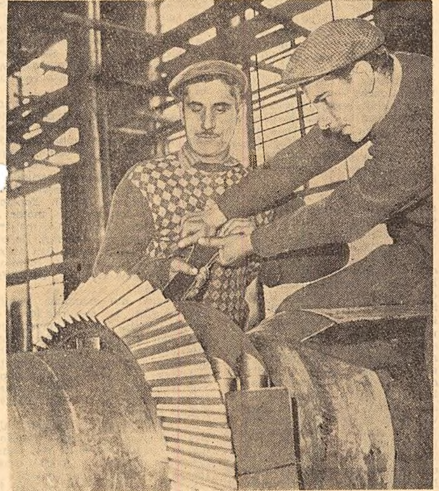
Pe șantierul Uzinei de produse sodice Govora. În fotografie: Montatorii Eugen Birsan și Teodor Petrescu lucrînd la montajul axului principal al compresorului nr. 4. (Foto M. Cioc)
