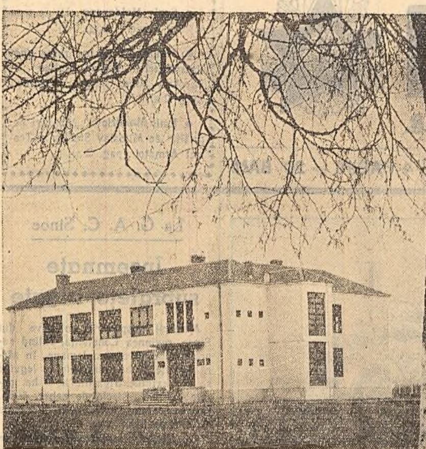
La Craiova, a fost dat în folosință o clădire unde își duc activitatea stațiunea experimentală a Institutului de cercetări forestiere. Fotografia reprezintă noua clădire a Institutului. (Foto Gh. Vințilă)
